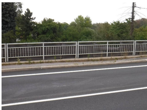
Obrázek 15 – Stav vozovky mezi stěnami, poklesy povrchu chodníku a obrub proti monolitickým římsám na stěnách
