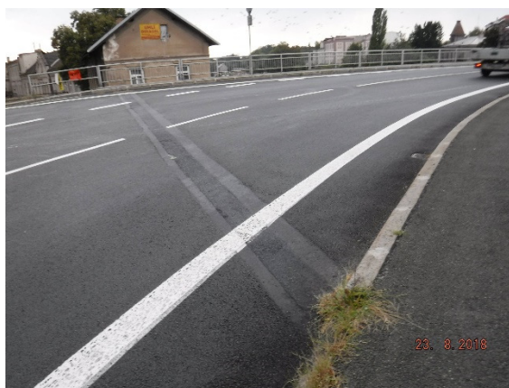
Obrázek 10 – Mostní závěry na opěrách mostu (vlevo opěra O1, vpravo opěra O4)
