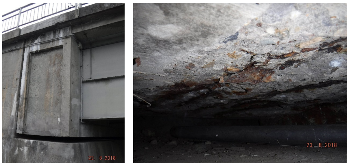
Obrázek 8 – Příklady zatékání a jeho důsledků na koncové příčky
