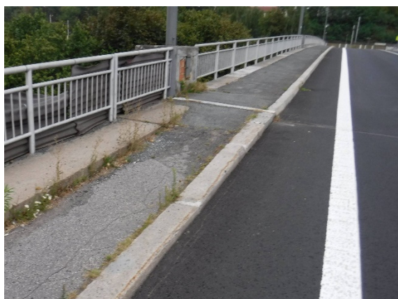
Obrázek 10 – Mostní závěry na opěrách mostu (vlevo opěra O1, vpravo opěra O4)
