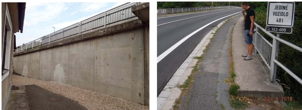
Obrázek 14 – Typický stav římsy na opěrných stěnách
