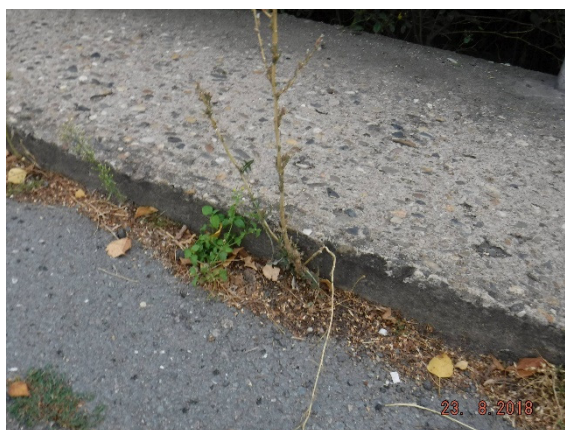
Obrázek 15 – Stav vozovky mezi stěnami, poklesy povrchu chodníku a obrub proti monolitickým římsám na stěnách
