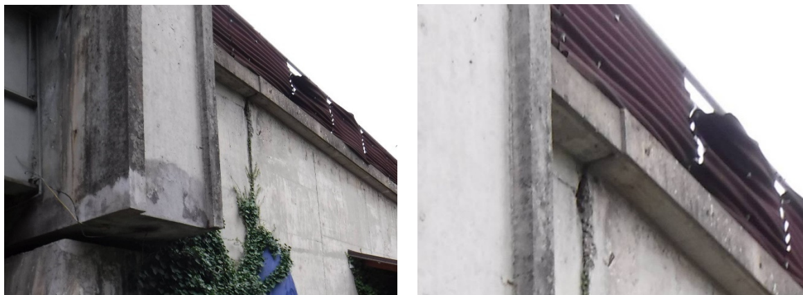
Obrázek 12 – Vodorovný posun (cca 30 mm) v dilatační spáře vlevo u opěry O1
