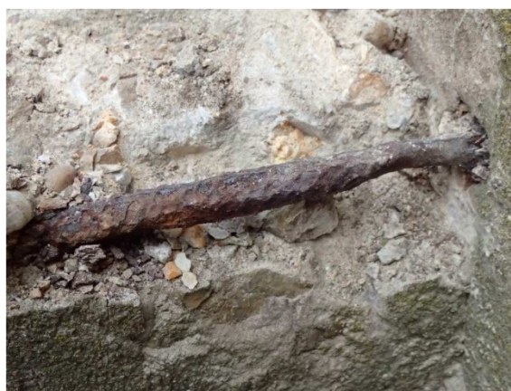
Obrázek 16 – Přístupové schodiště a typický stav výztuže na hranách schodnic (oslabení až o 70 %)
