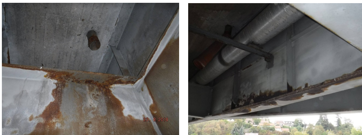
Obrázek 7 – Typické důsledky zatékání na ocelovou konstrukci mostu
