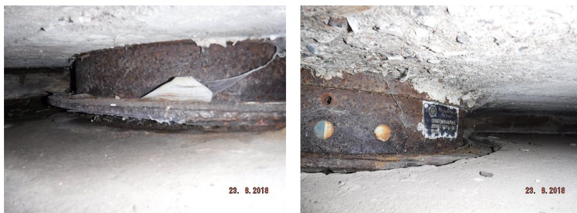
Obrázek 9 – Stav ložiska vlevo na opěře O4, kaverna pod ložiskem a chybějící PKO
